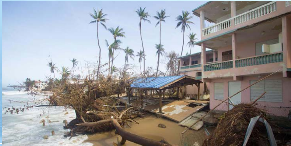
Rincon, PR – Daños post Huracán Maria
